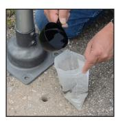
SLOWLY MIX APX. 3/8 CUP WATER WITH GROUT MIXTURE (DON'T DUMP ALL THE WATER, ADD JUST A LITTLE AT A TIME)
